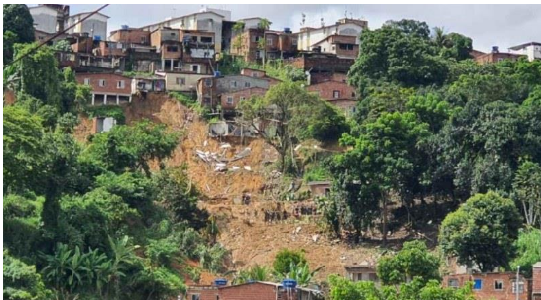
Figura 2.3 – Uma das áreas atingidas por deslizamentos generalizados desencadeados em Recife (PE), em junho de 2022, após chuvas intensas.
