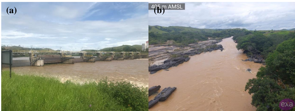
Figura 5. Barramento da estação elevatória Santa Cecília (esquerda) e seção do rio após a transposição (direita).
