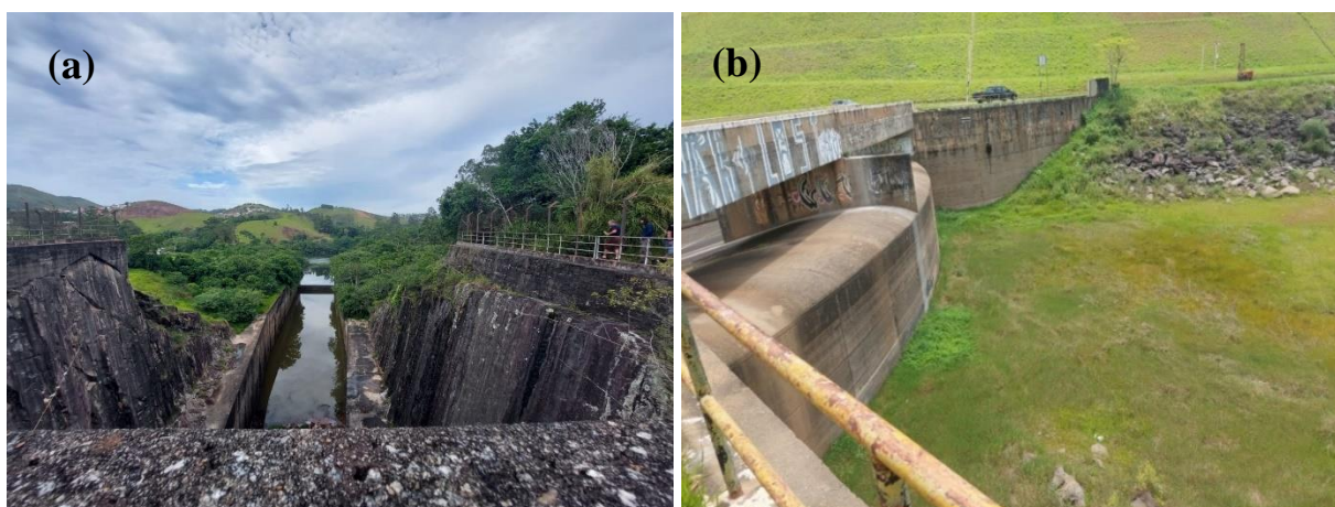
Figura 4. Vertedores do Reservatório da UHE Paraibuna (esquerda) e do Reservatório da elevatória do Jaguari (direita).
