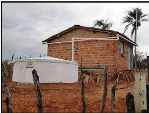
Figura 4 - Imagem de uma Cisterna de Placa de 16 mil litros funcional. Fonte: Vítor Leal Santana, agosto 2011.
