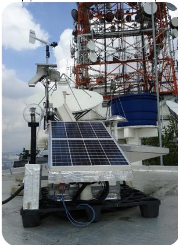
Figura 3.1 – Equipamentos a 27 m da torre T 1 no pico do Jaraguá.
