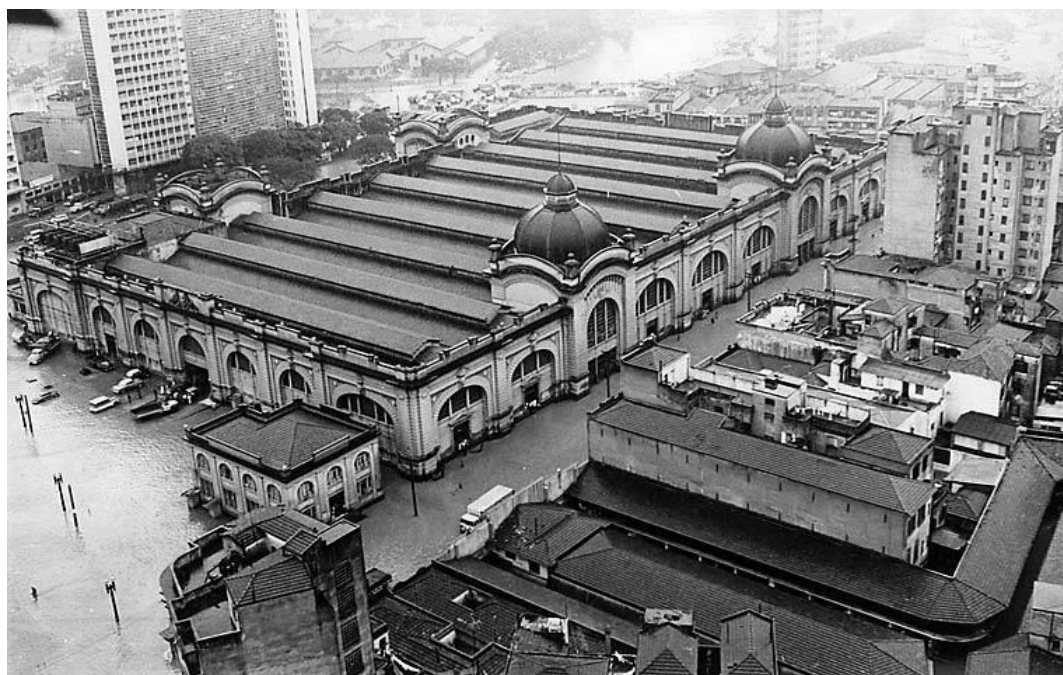
Figura 4.15 : Inundação na região do Mercado Municipal.
