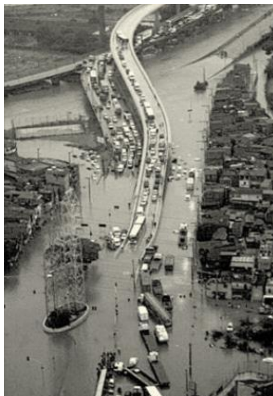
Figura 4.21: Inundação rio Tamanduateí, Viaduto Grande São Paulo.
