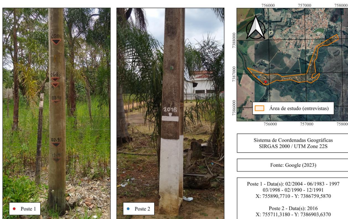
Figura 2 – Postes de luz com marcações de altura da água das inundações
