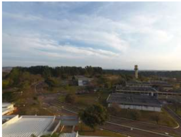
Figura 2.14- Imagem 2 capturada do prédio
