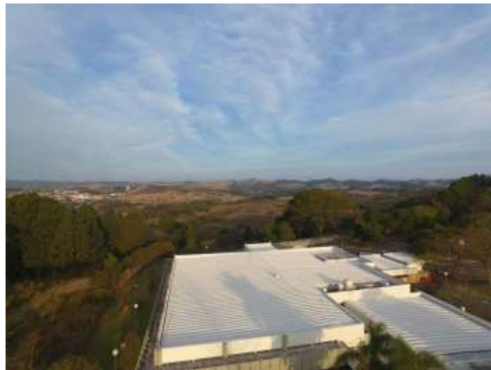
Figura 2.13- imagem 1 capturada do prédio
