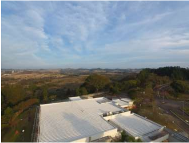
Figura 1.1: Imagem do prédio analisado
