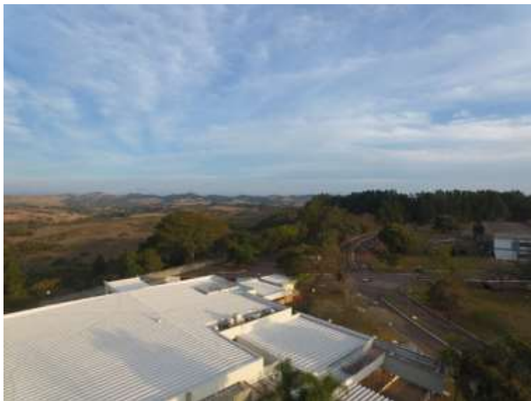
Figura 1.2: Imagem do prédio analisado
