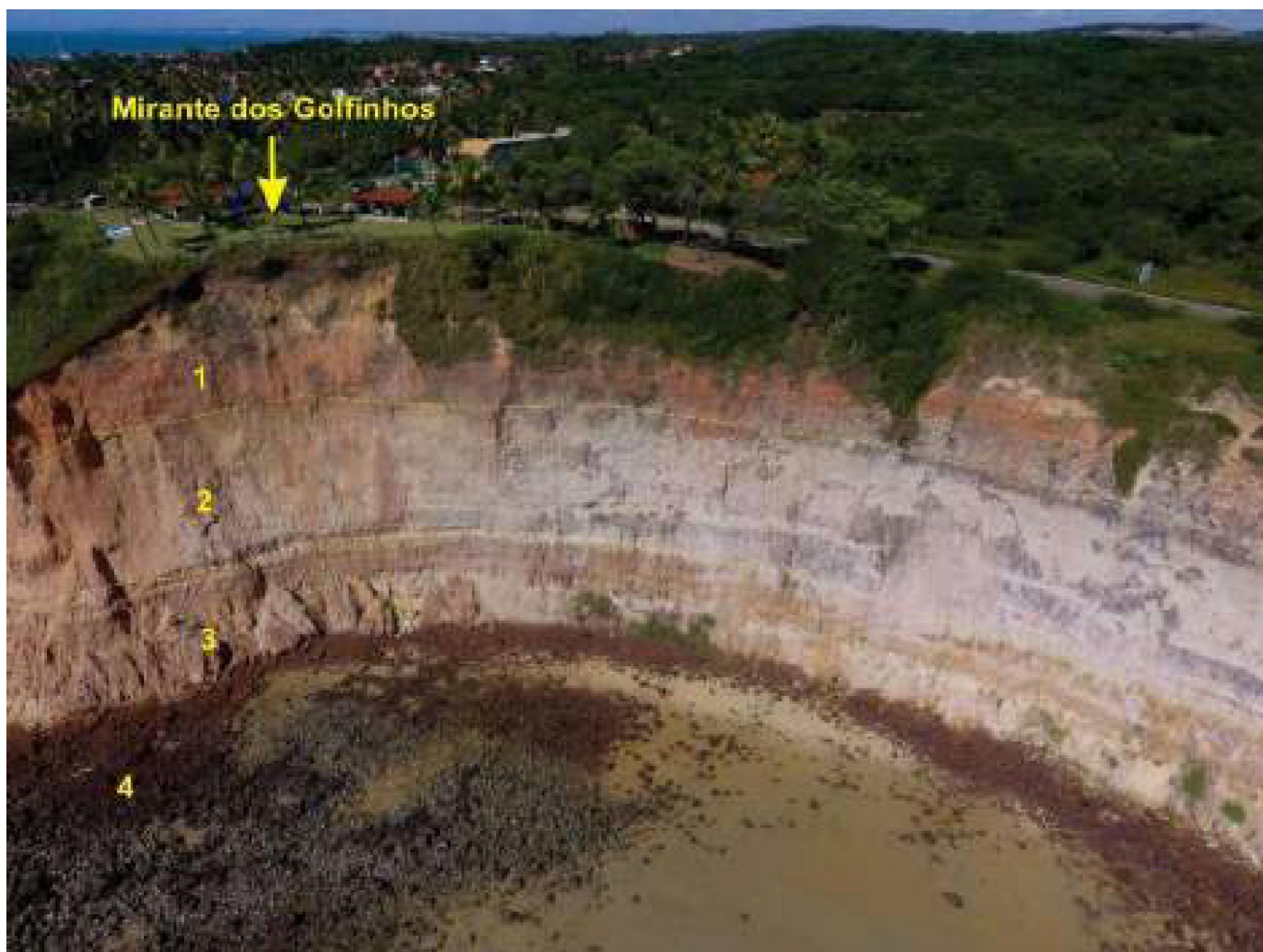
Figura 9. Diferentes níveis de cimentação na face da falésia diferenciados pela coloração.
