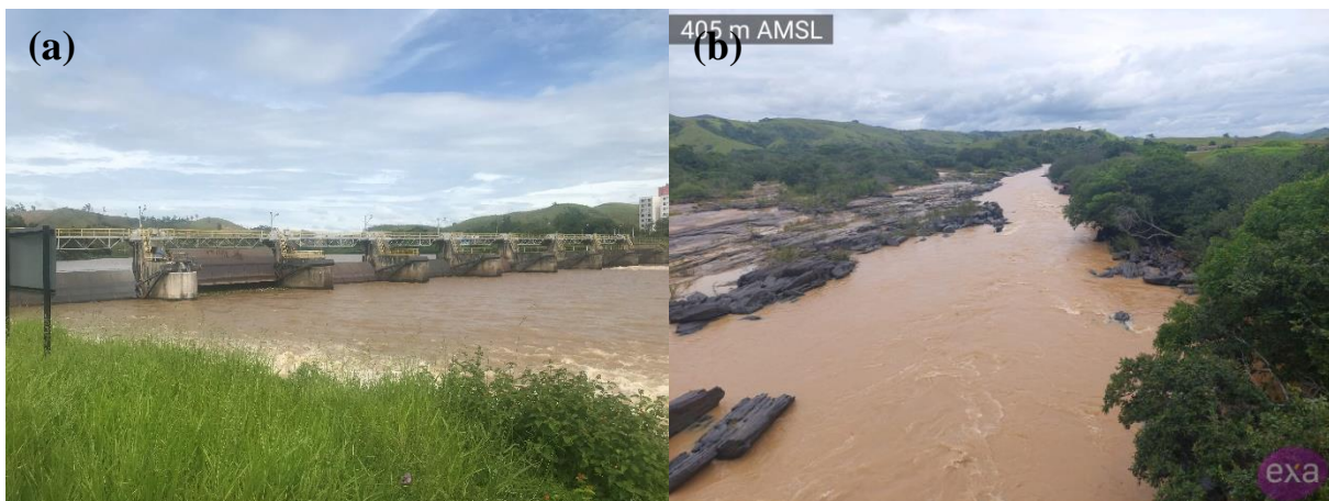
Figura 5. Barramento da estação elevatória Santa Cecília (esquerda) e seção do rio após a transposição (direita).
